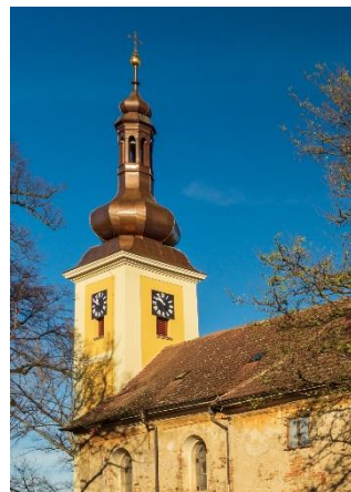
Kostel sv. Bartoloměje v Solopyskáč, obnovená věž. Autor fotografie: Josef Mrhák
