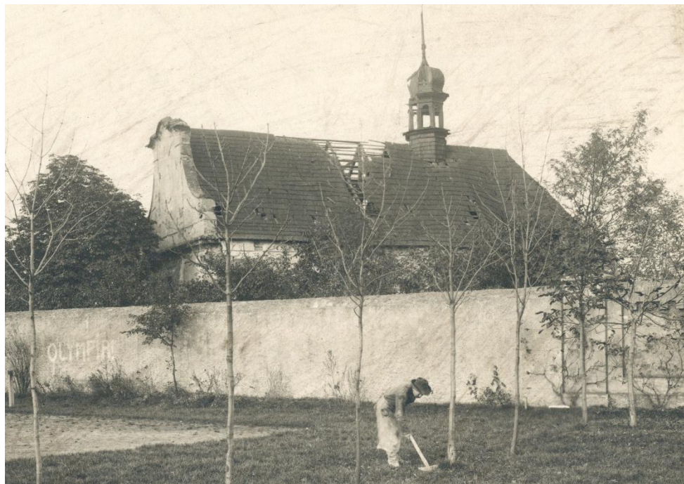
Kostelík Všech svatých před opravou v letech 1912–1913. Foto SOkA Kolín.
